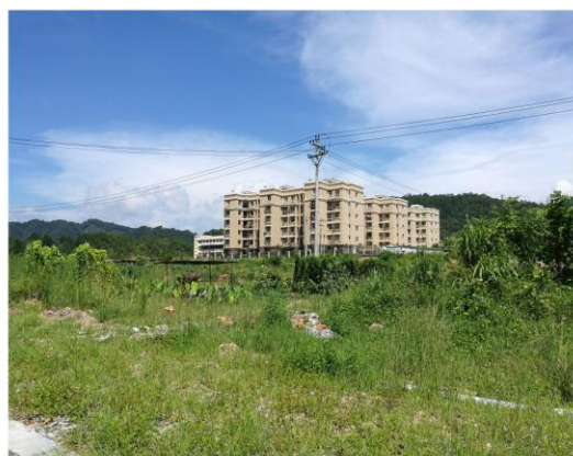
厂区北侧现状
