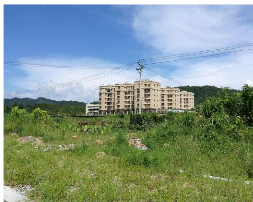
厂区北侧现状
