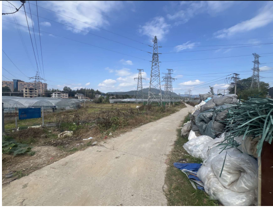
嵩溪 110kV 变电站西北侧现状
