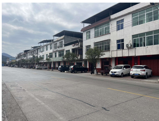
嵩溪 110kV 变电站西南侧现状
