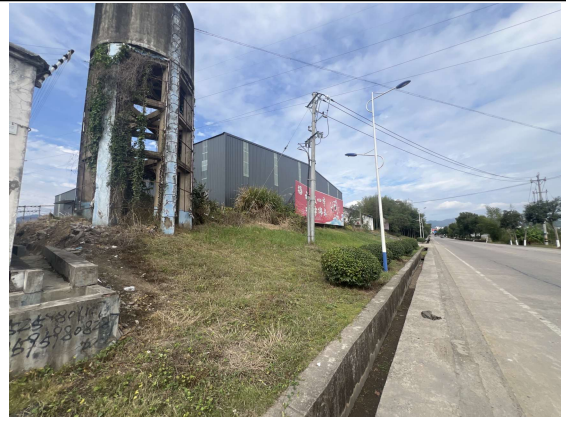
嵩溪 110kV 变电站东北侧现状
