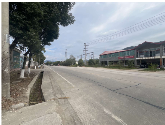
嵩溪 110kV 变电站东南侧现状
