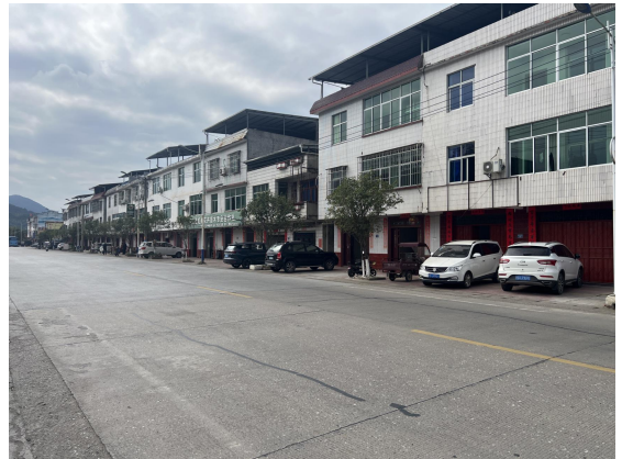
嵩溪 110kV 变电站西南侧现状
