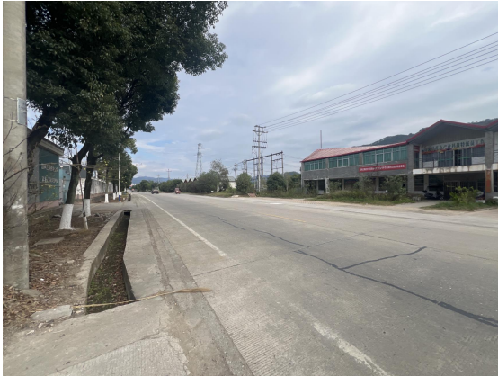
嵩溪 110kV 变电站东南侧现状
