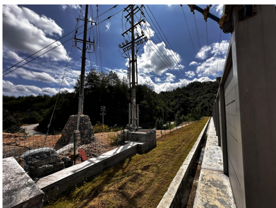
福宝 110kV 变电站东南侧现状
