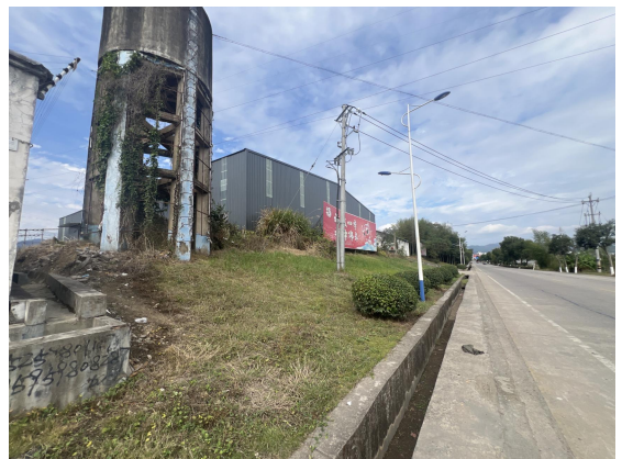
嵩溪 110kV 变电站东北侧现状
