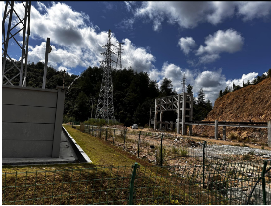
福宝 110kV 变电站西北侧现状
