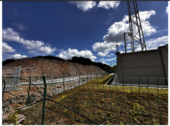
福宝 110kV 变电站东北侧现状
