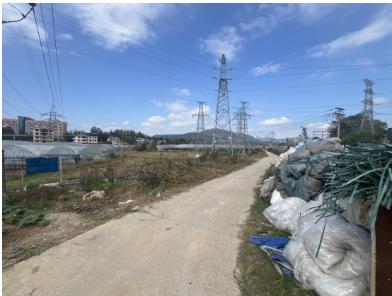
嵩溪 110kV 变电站西北侧现状
